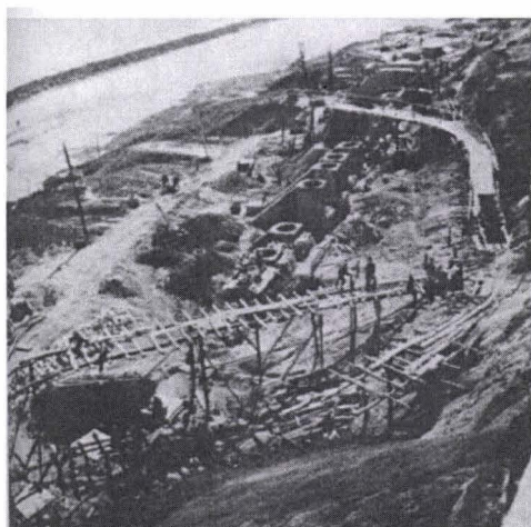
Fig. 20 – Imagine de la lucrările la faleza nord-estică 1956-1957.
